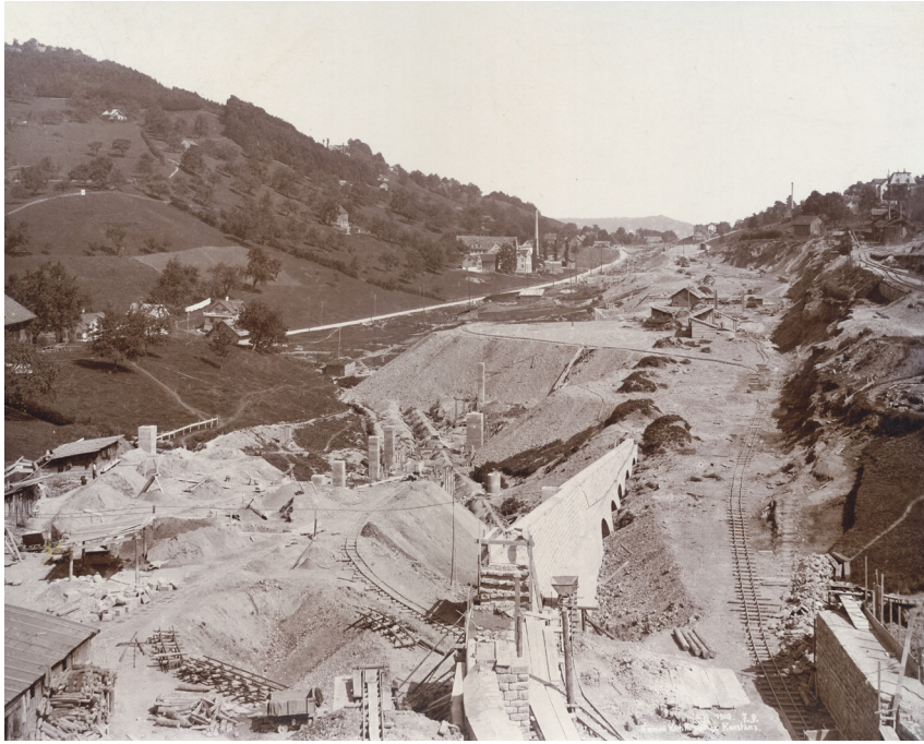
Die Grossbaustelle für den neuen Bahnhof im Sommer 1908. (Gemeindearchiv Herisau)
