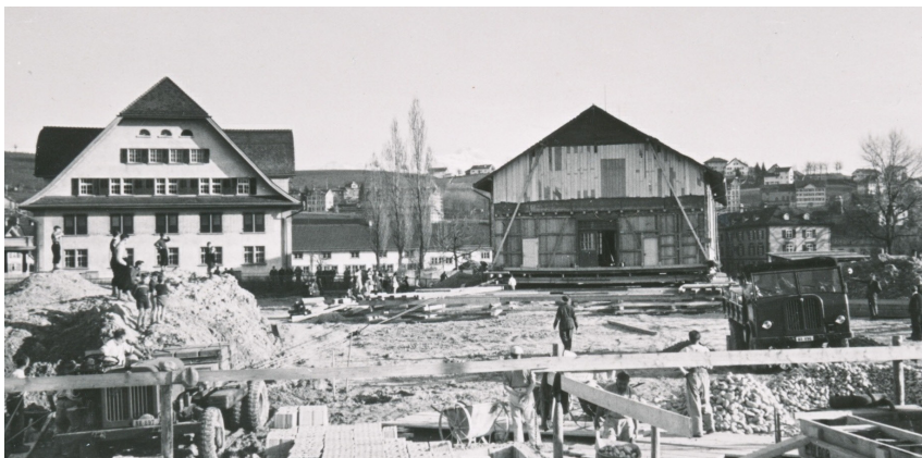
Verschiebung der Turnhalle, 1952. Sie wurde mit zwei Lastwagen gut 200 Meter verschoben und um 90 Grad gedreht. (Museum Herisau)
