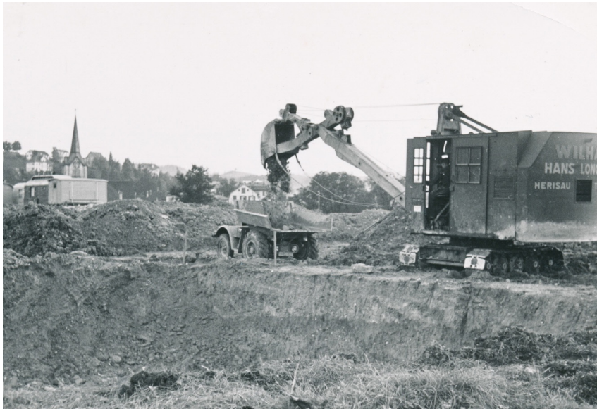
Aushubarbeiten für das Sekundarschulhaus, 1951. (Museum Herisau)
